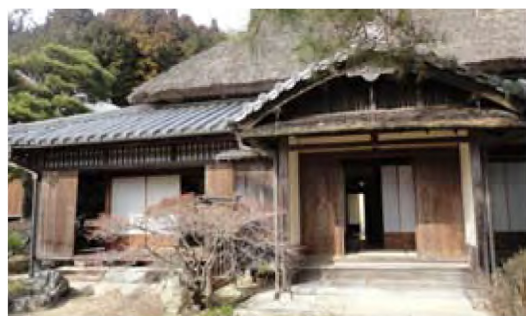
↑入母屋造りの母屋の天井裏には隠し部屋も
